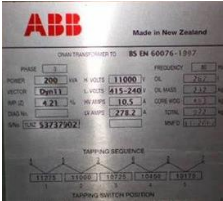
شكل رقم ١١: لوحة بيانات محول كهربائي
